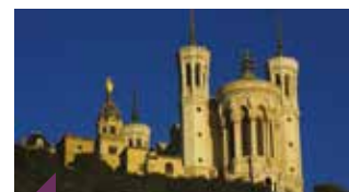
La Fondation Fourvière innove avec la mise en place d'une collecte de fond sur internet pour soutenir la construction du Pavillon d'Accueil.
