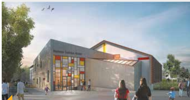
La maison Saint-Anne sera implantée au cœur d'un quartier en plein travaux, destiné à devenir un second centre à Villefranche.
